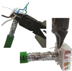
Couper les fils au raz du passe fils et couper le drain\*.
