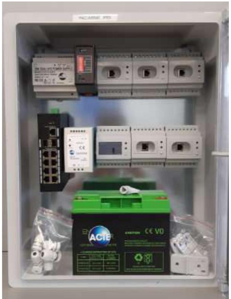
\*Photo d'illustration: exemple d'installation avec: Alimentation 12v-5a UPS, ADIP-DIN, batterie 12v - 18ah, etc (non livrés)
