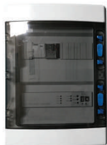
Système AE CGLine+ sans alimentation de secours
