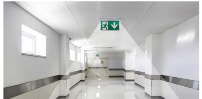
Pose plafond : Éclairage couloir
