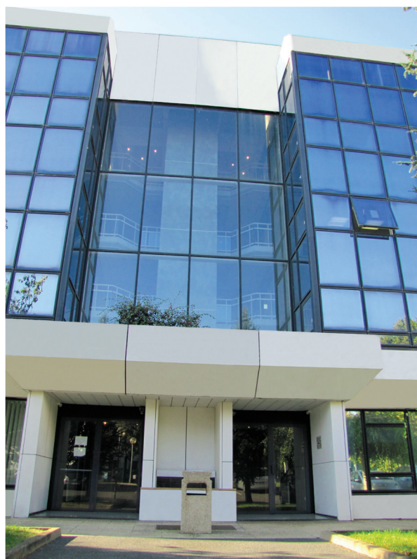
Showroom parisien à Gennevilliers (92)
